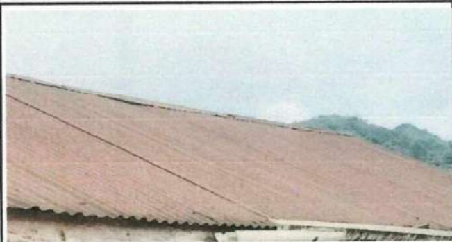
Foto 1: Sustrucion de estructura de techo.
