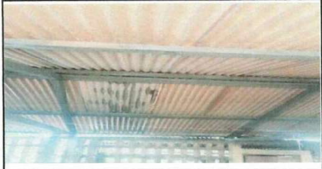
Foto 4: Sustrucion de cubierto de lamina.
