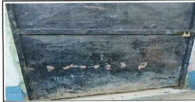
Foto 6: Mantenimiento de puertas.
